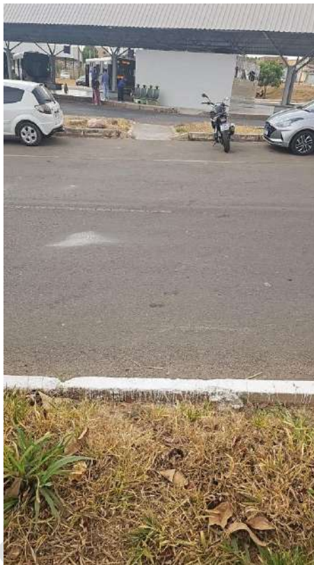
Figura 19 - Acesso sem faixa de pedestre e sinalização vertical.
