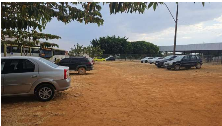
Figura 18 - Inexistência de estacionamento para veículos individuais.
