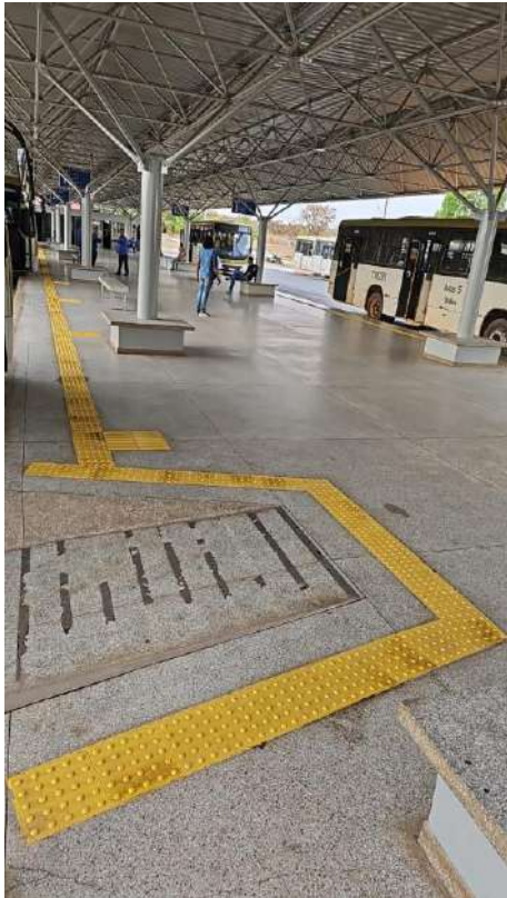
Figura 25 - Rampa e piso tátil.
